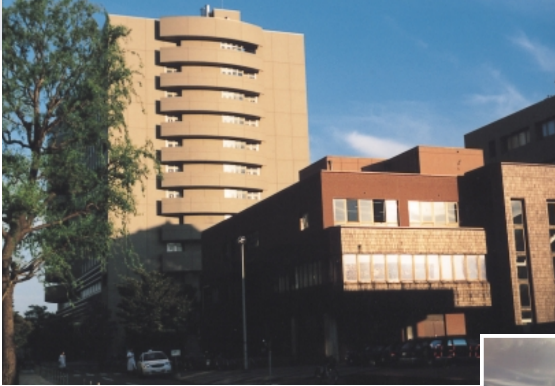
第一期工事で完成した病棟
