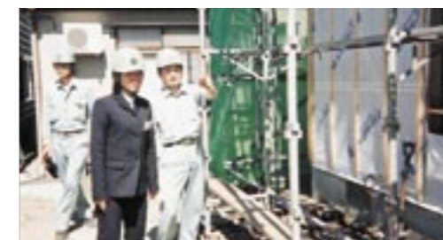
社員の方と一緒に工事現場を見学
