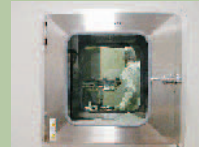
細胞保存室からパスボックスを通じてCPC内を見る
