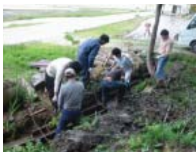
5/21 川口町にて 側溝の泥揚げ作業
