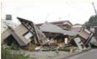
建物被害 (川口町・長岡:2004年新潟県中越地震)
