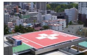
↑屋上ヘリポート
