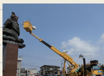
高さ10mのモニュメントの汚れを落としました
