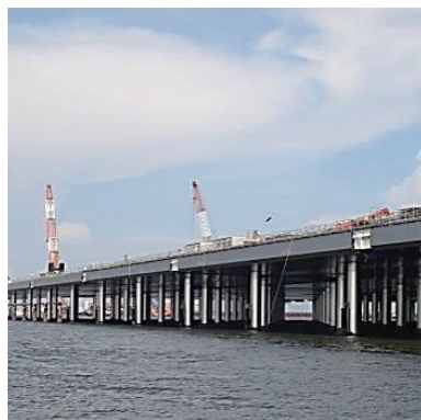
羽田空港 洋上滑走路
