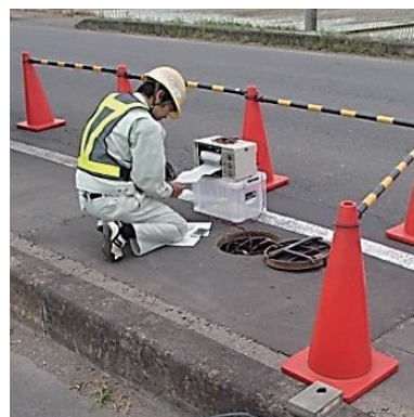
ガス管点検の様子
