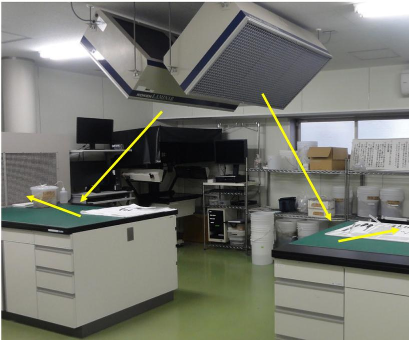
図1 プレインカッティングルームに備え付けられたプッシュプル式排気装置エアフローの概略を黄色矢印で示す。
