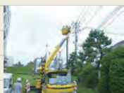
受変電設備定期点検業務状況
