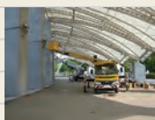
鳥屋野潟スポーツ公園内照明灯清掃状況
