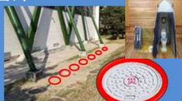
マンホールトイレ（体育館）
