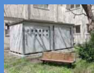
備蓄倉庫 （保健学科）
